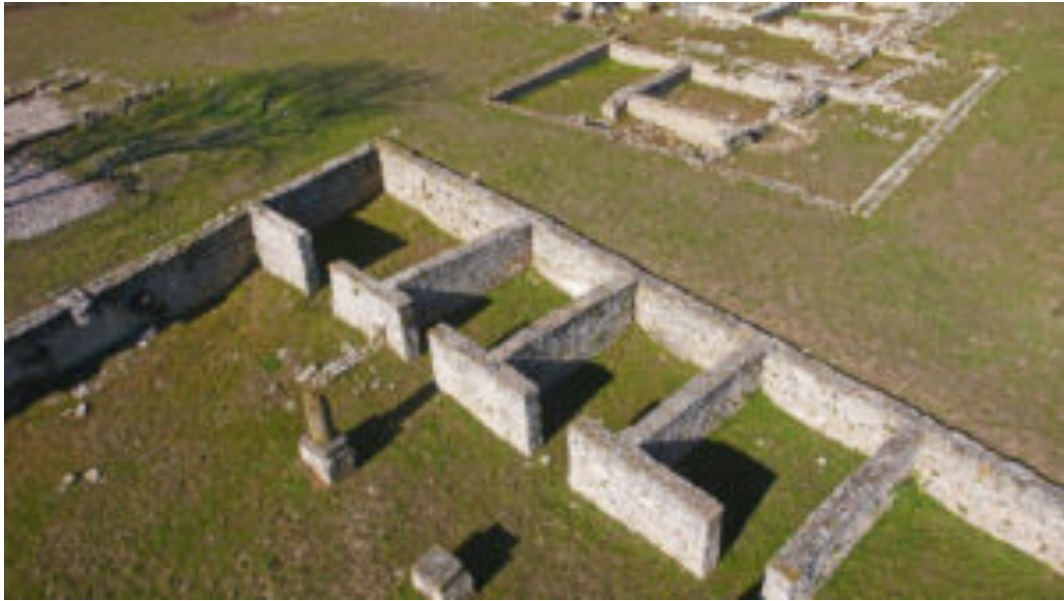
Chambres de l'auberge du relais routier.
